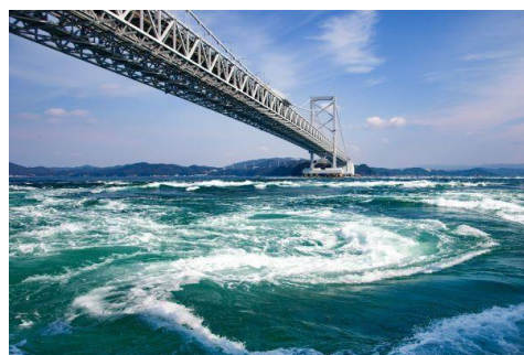
鳴門大橋漩渦奇趣走廊
